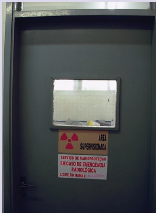
Figura 42.3 – Identificação das salas de experimentação.
