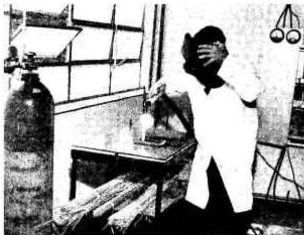
Fig. 8 — Solda do conjunto encerrando o "cermet" de  $U_{235}$  com 20% de  $U_{235}$ , pelo processo "argon arc".
